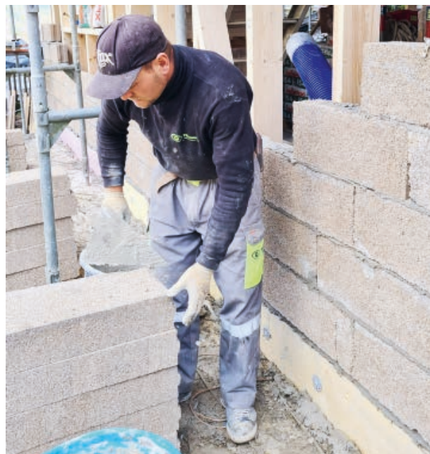
Einbau von Hanfsteinen als Aussenwanddämmung. (Bild: hanfhandwerk.ch)
